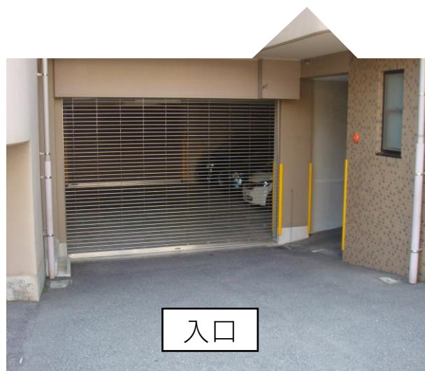
※リモコンシャッター付き駐車場
